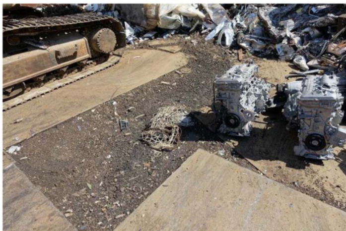
図 4 土壌・地下水汚染防止対策が不十分な床面
