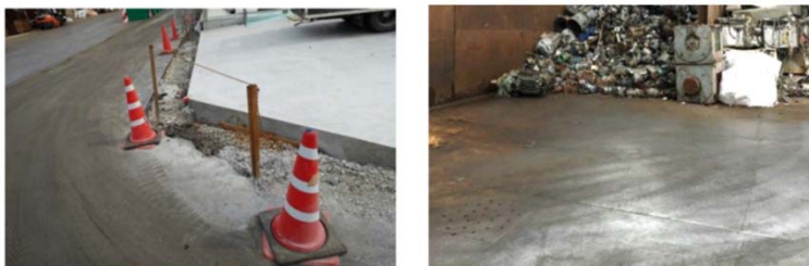
図 3 地下浸透防止策の事例
